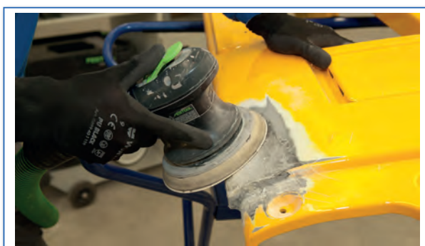
9 Lijar el material sobrante, dando forma a la superficie exterior.
