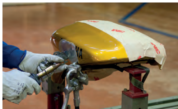
Soldadura de arandelas en la zona deformada.
