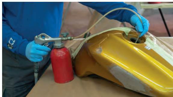
Aplicación interior de imprimación anticorrosiva.
