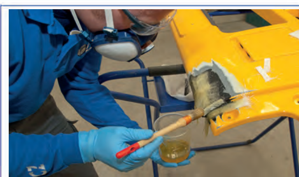
8 Rellenar la superficie dañado con capas alternas de resina y fibra.
